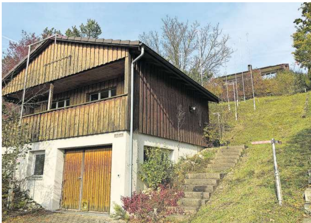
Das kleine alte Einfamilienhaus muss der Terrassensiedlung weichen.
